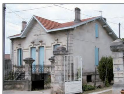
L'expression du style recherche le pittoresque, et utilise les matériaux nouveaux : briques pour les murs, tuiles mécaniques pour les toitures, et parfois ciment façon rocaille pour les balcons.
